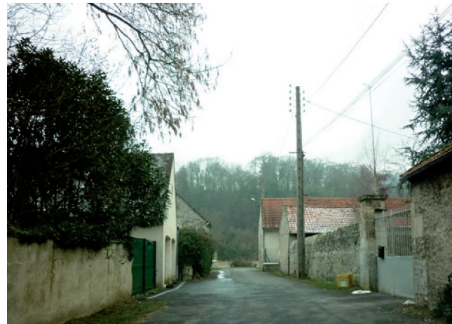
La rue de la Cavée Martine est singulière par sa relation directe sur le coteau qu'elle invite dans l'espace urbanisé. Dans cette rue, les volumes s'adossent perpendiculairement, dessinant un font bâti plus aéré.
